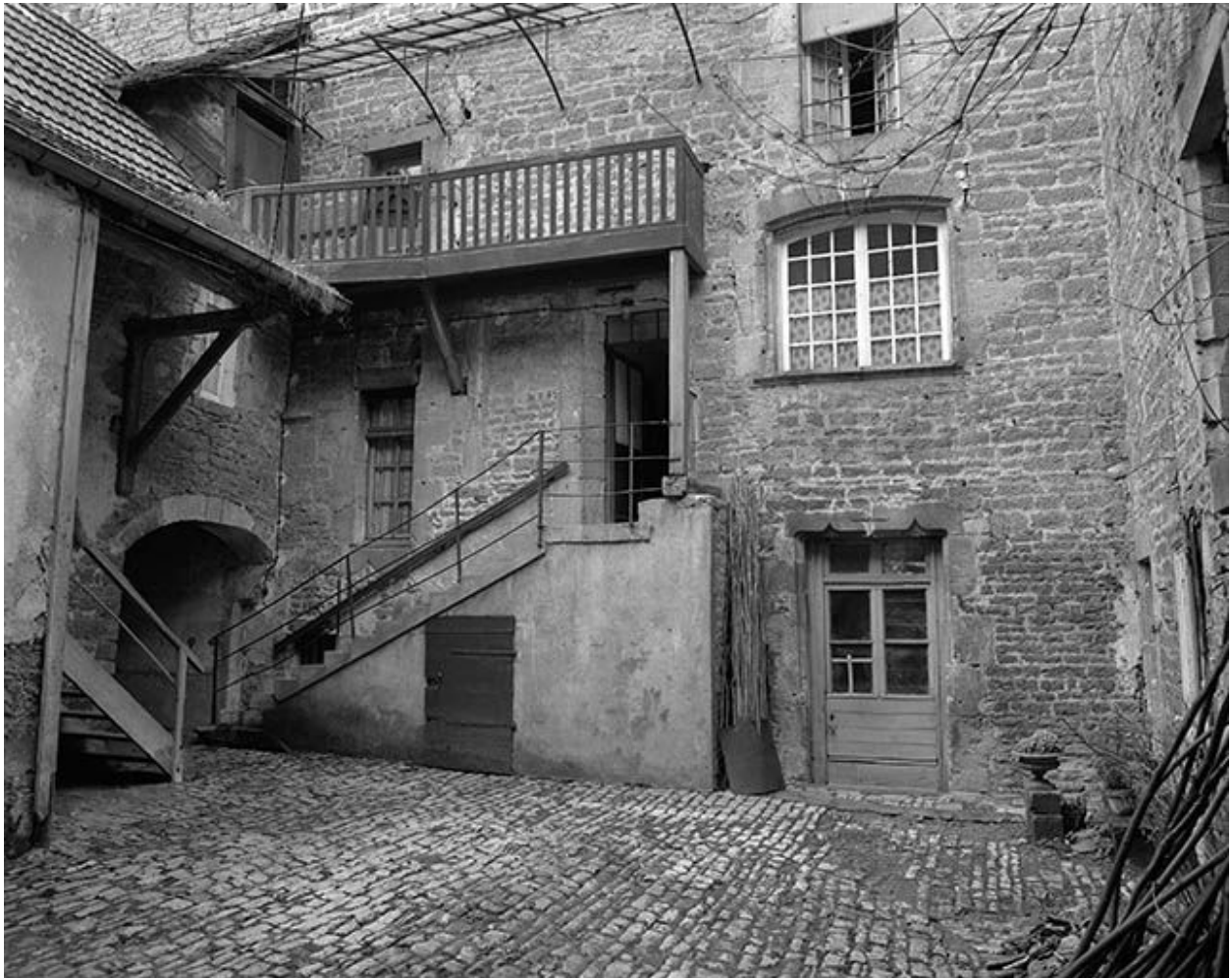
Maison 20 rue Saint-Laurent : élévation sur cour : rez-de-chaussée et 1er niveau.
