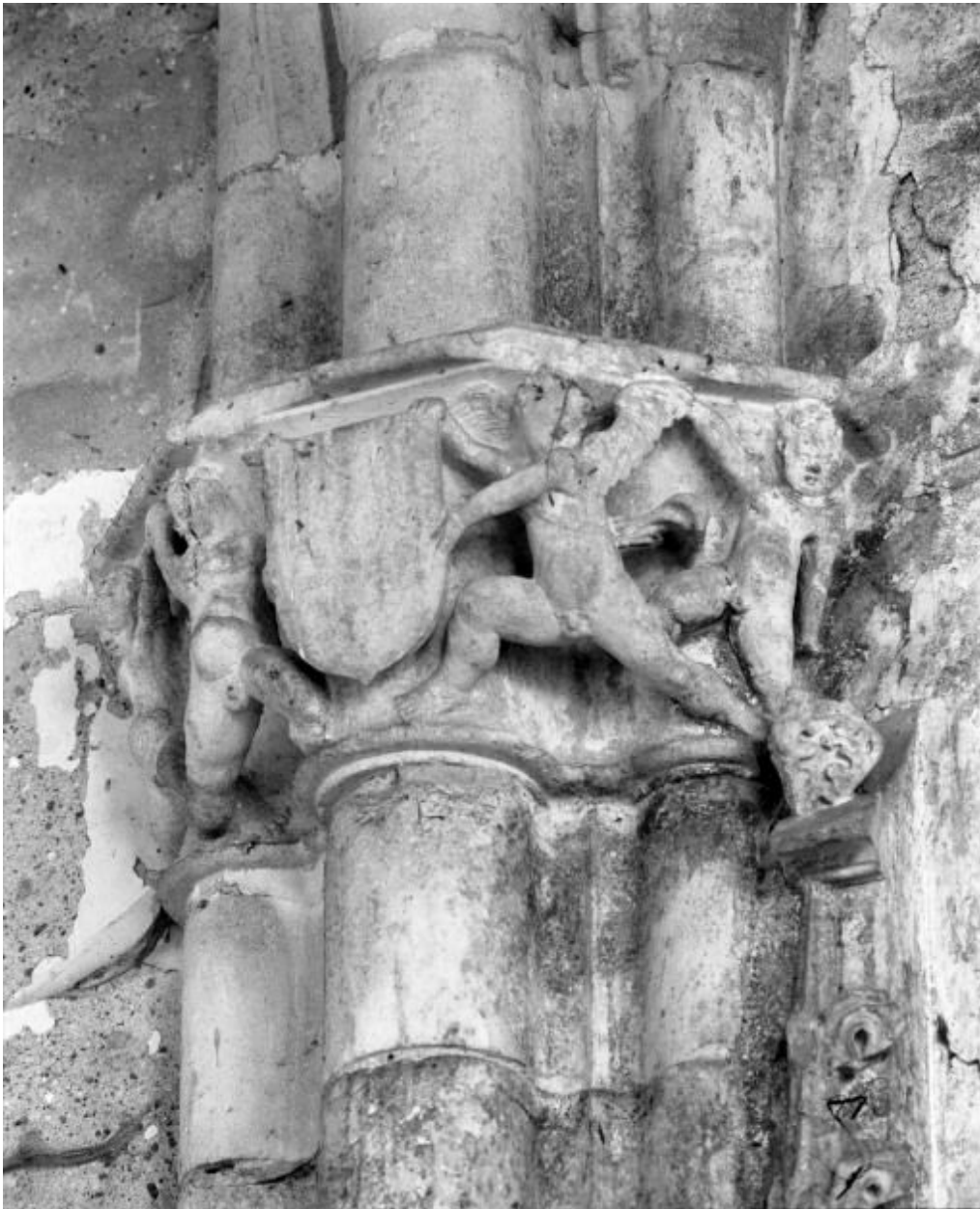
Entre la nef et le chœur, chapiteau gauche.
