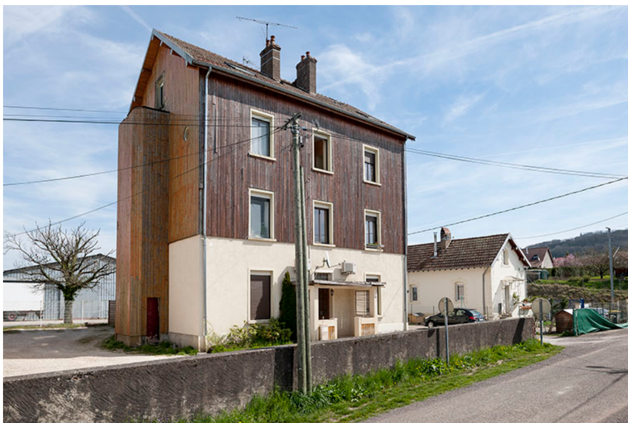
Ancien bâtiment de bureaux et logements.
