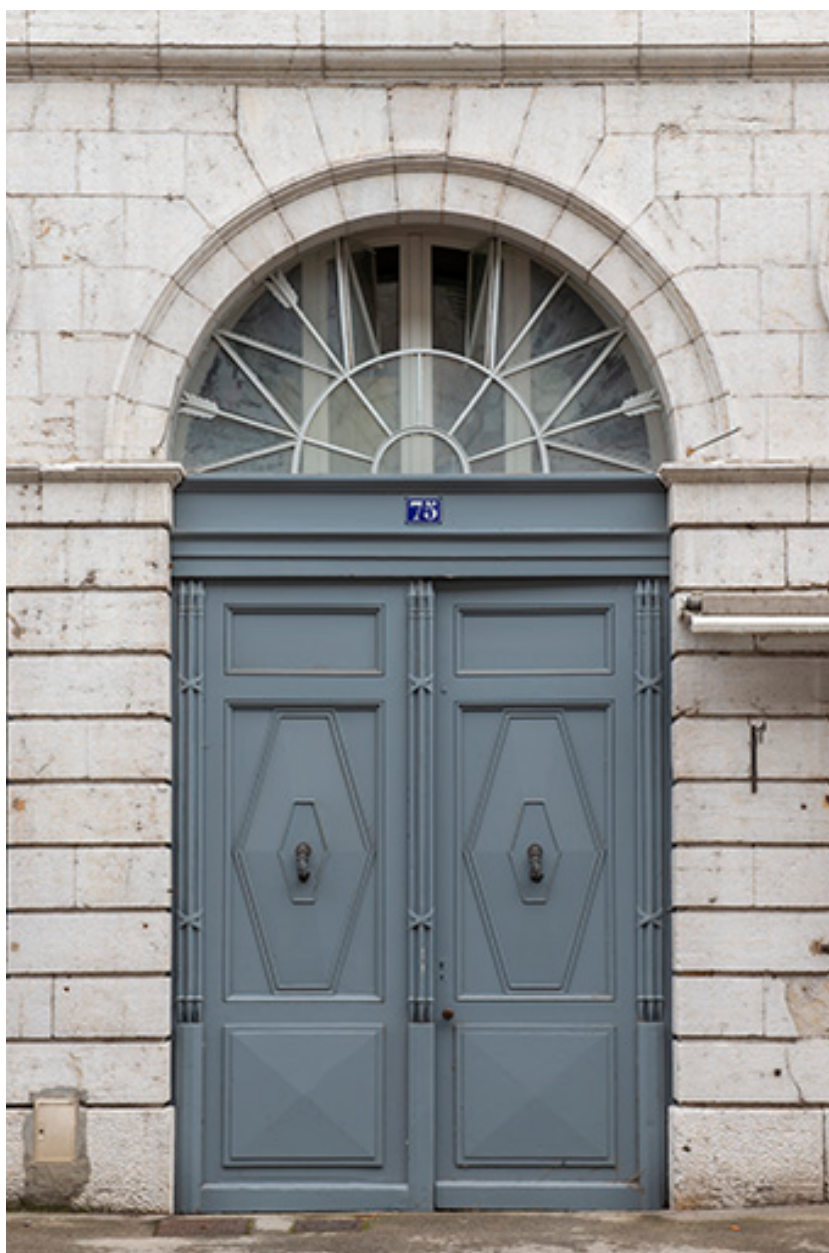
Détail de la porte cochère.
