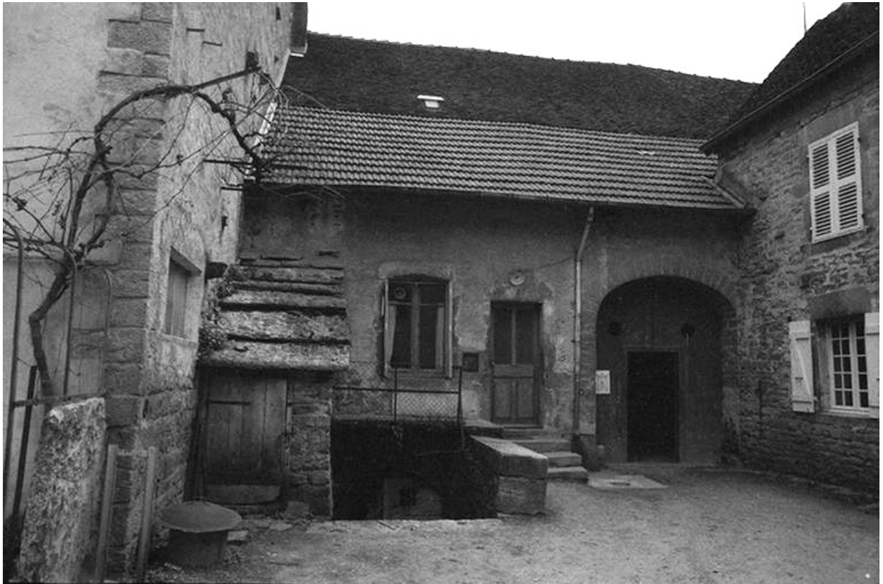
Maison de vigneron cadastrée 1961 AH 93, située rue du Presbytère : façade antérieure.
