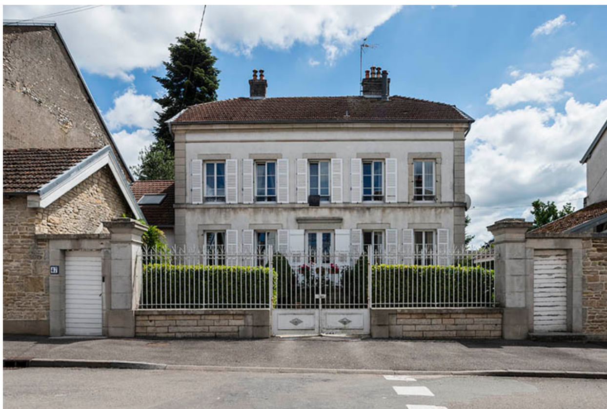
La façade antérieure.
