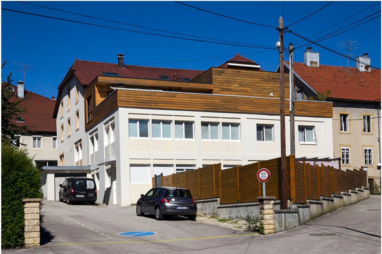
Façades postérieure et latérale droite.
