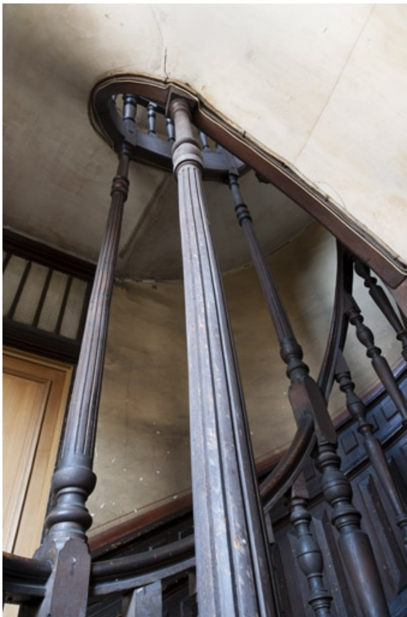
Détail des montants de l'escalier.
