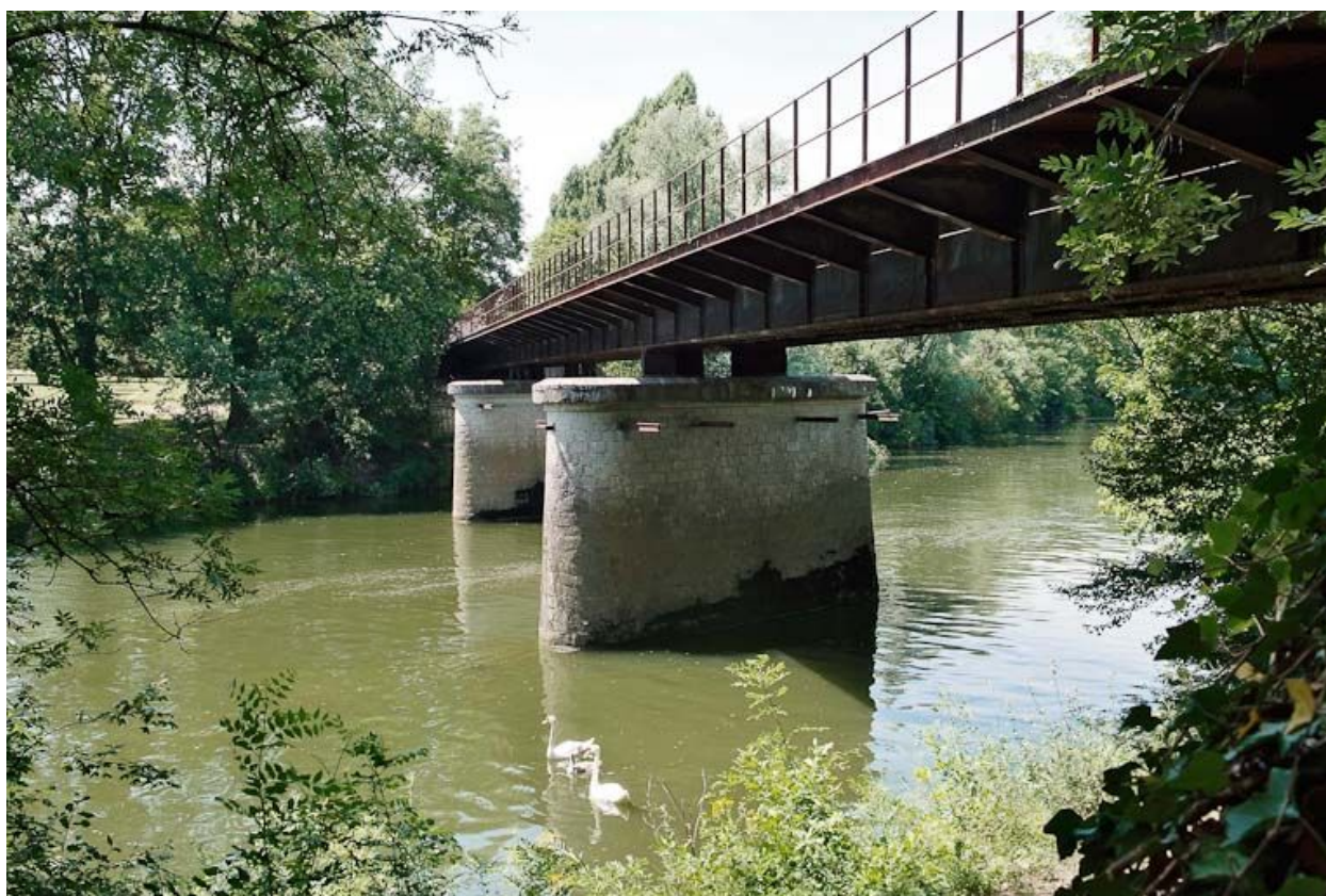
Pont de chemin de fer désaffecté.
