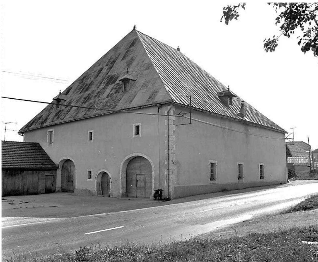
Ferme située 35 rue Principale.
