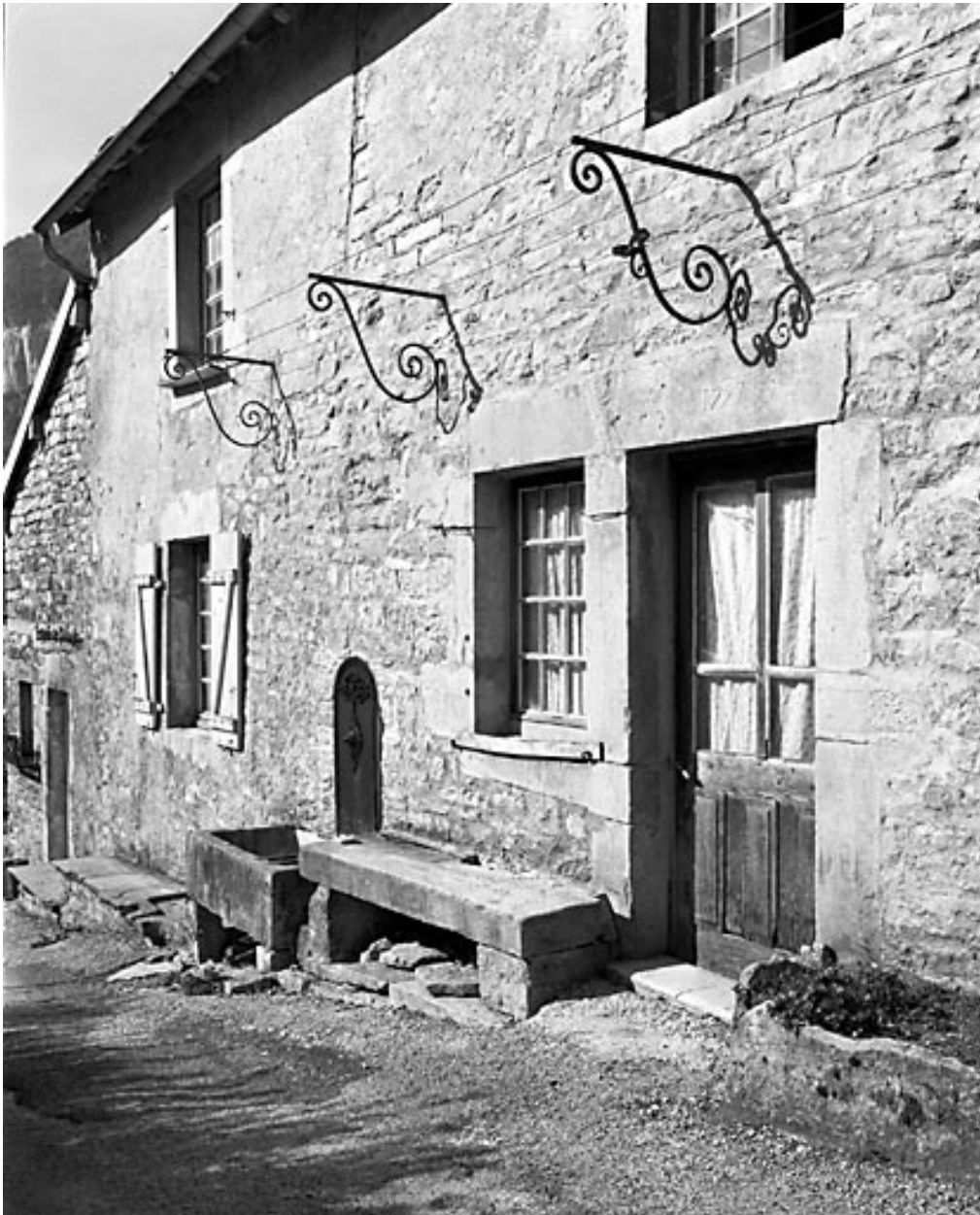
Détail de la façade est d'une maison de chanoine.
