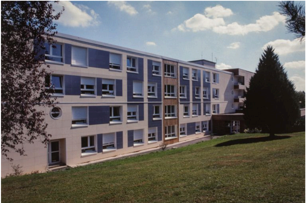
Maison de retraite, élévation latérale.
