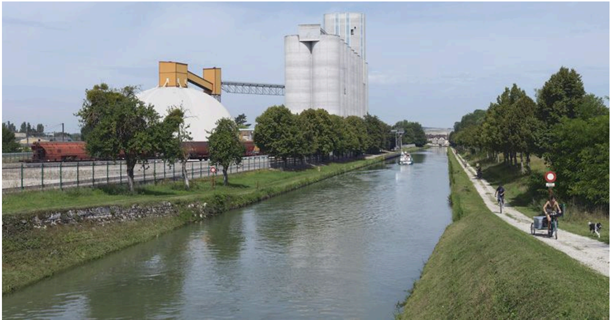
A Briennon-sur-Armançon, vue d'ensemble des silos avec accès par pont roulant au canal. A l'extrême-gauche, les voies SNCF.
