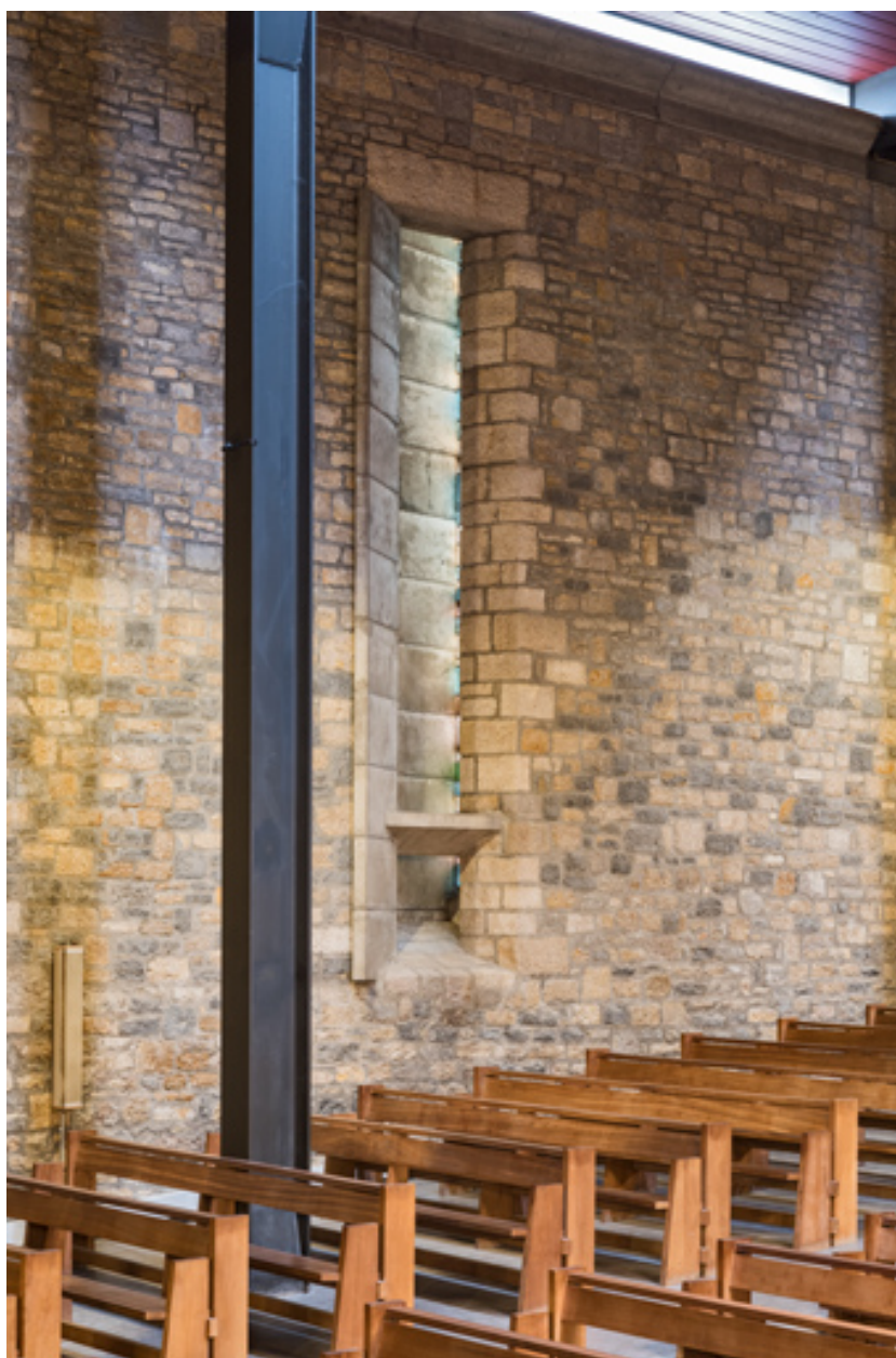
Baie du mur est. Vue de trois quarts.
