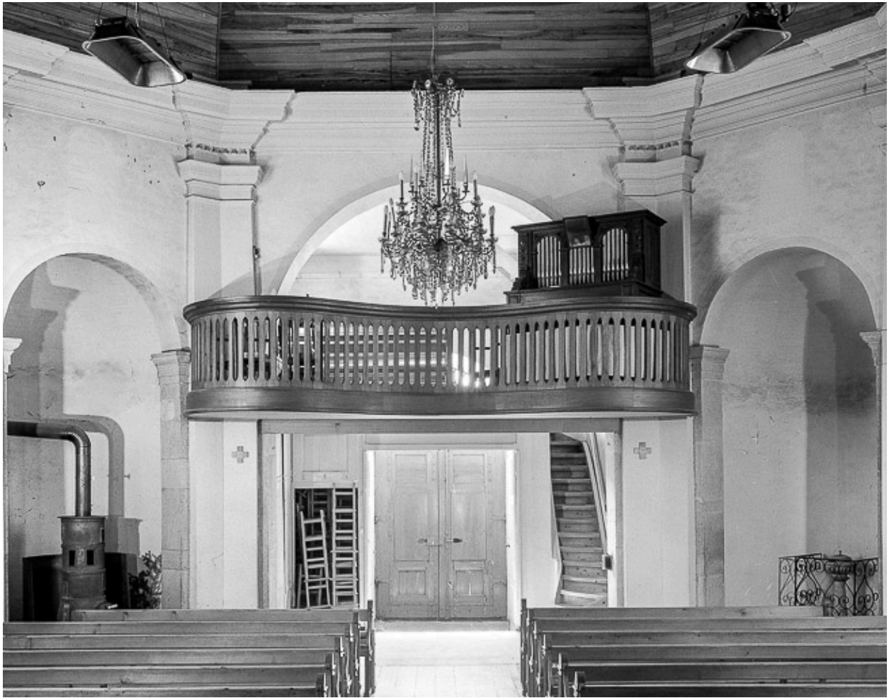
Intérieur : vue d'ensemble depuis le chœur.
