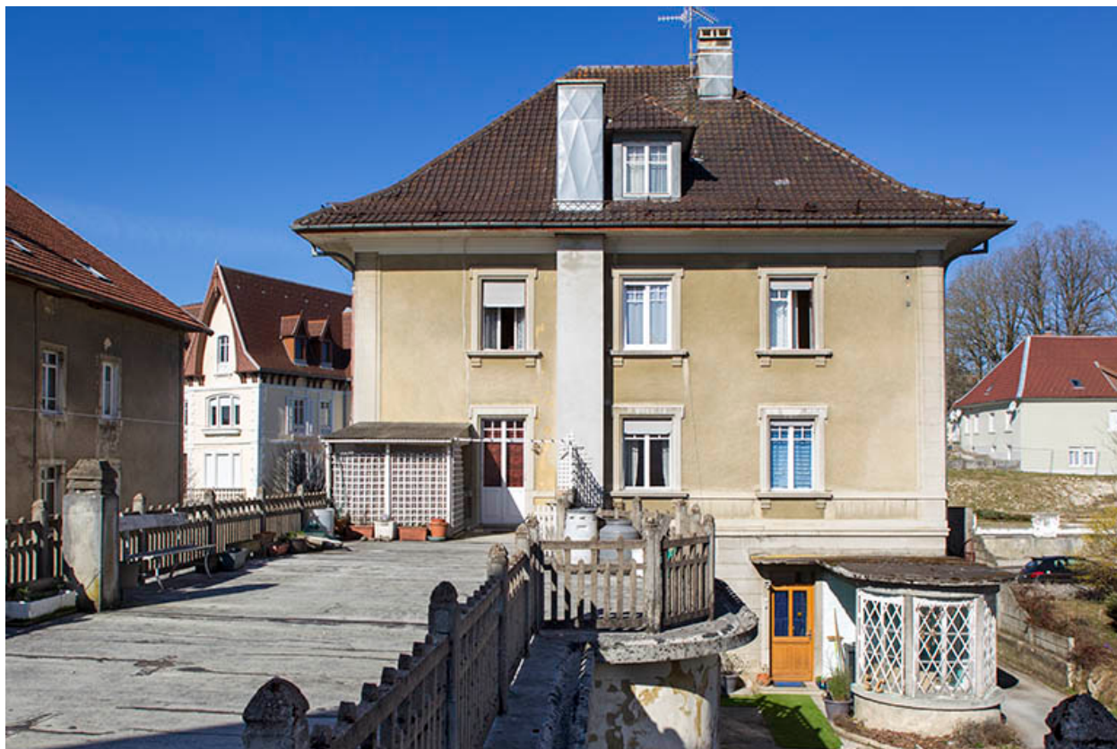
Façade postérieure et terrasse surmontant la cuisine.
