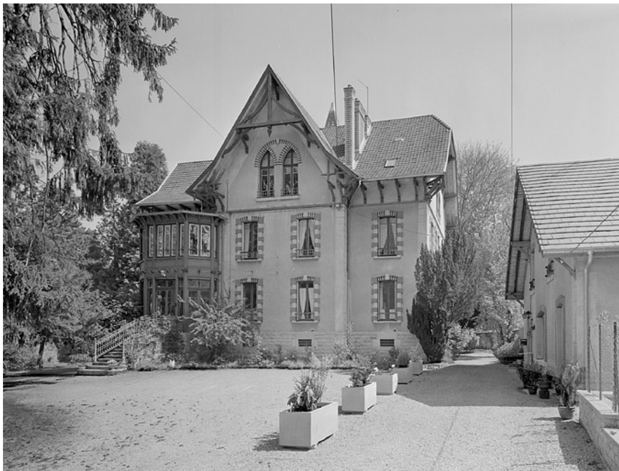
Logement patronal depuis l'ouest.
