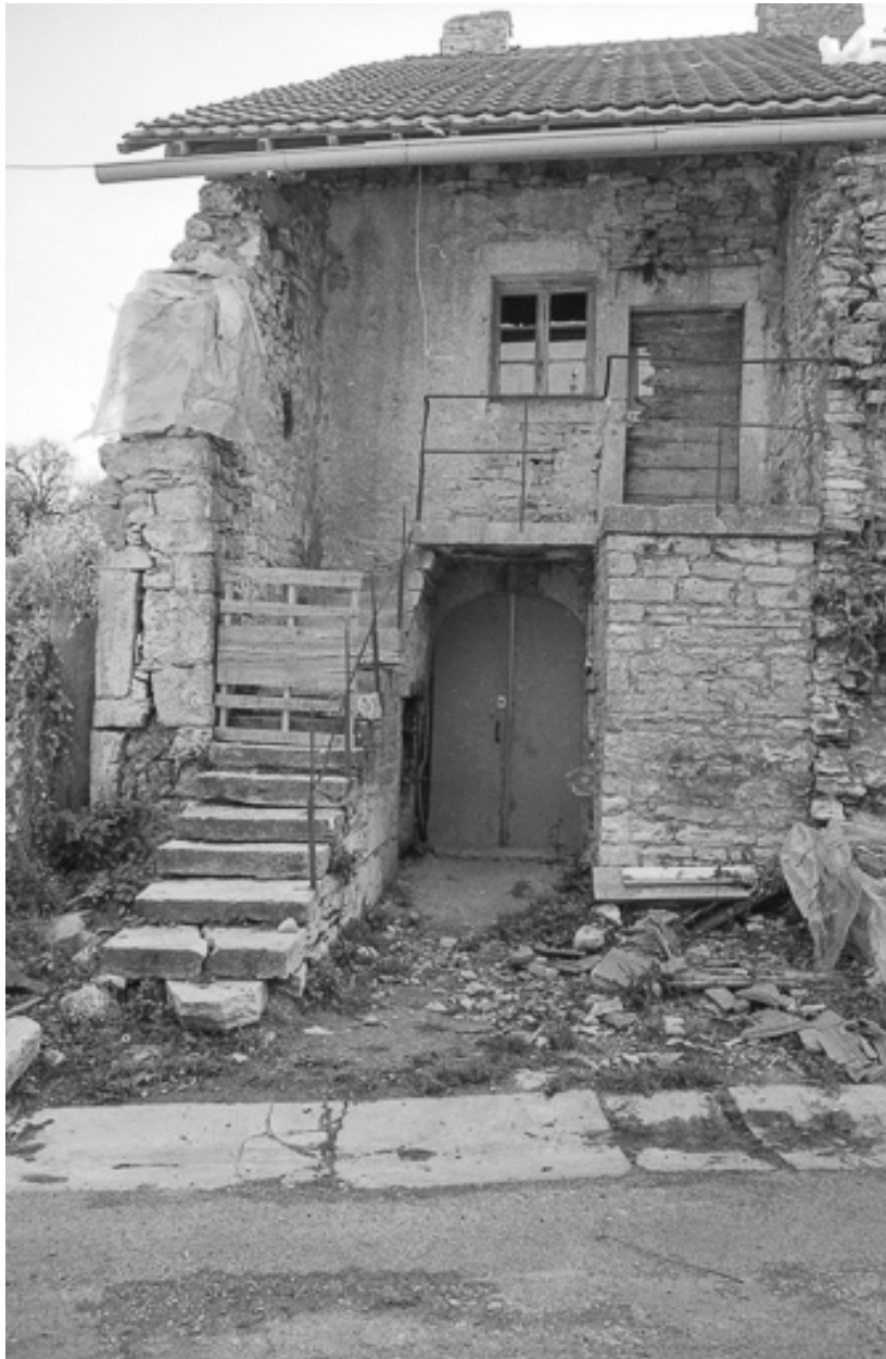
Façade antérieure, partie gauche.
