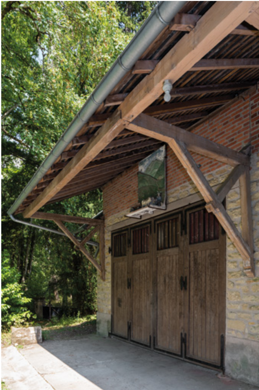
Entrée en façade nord-ouest.
