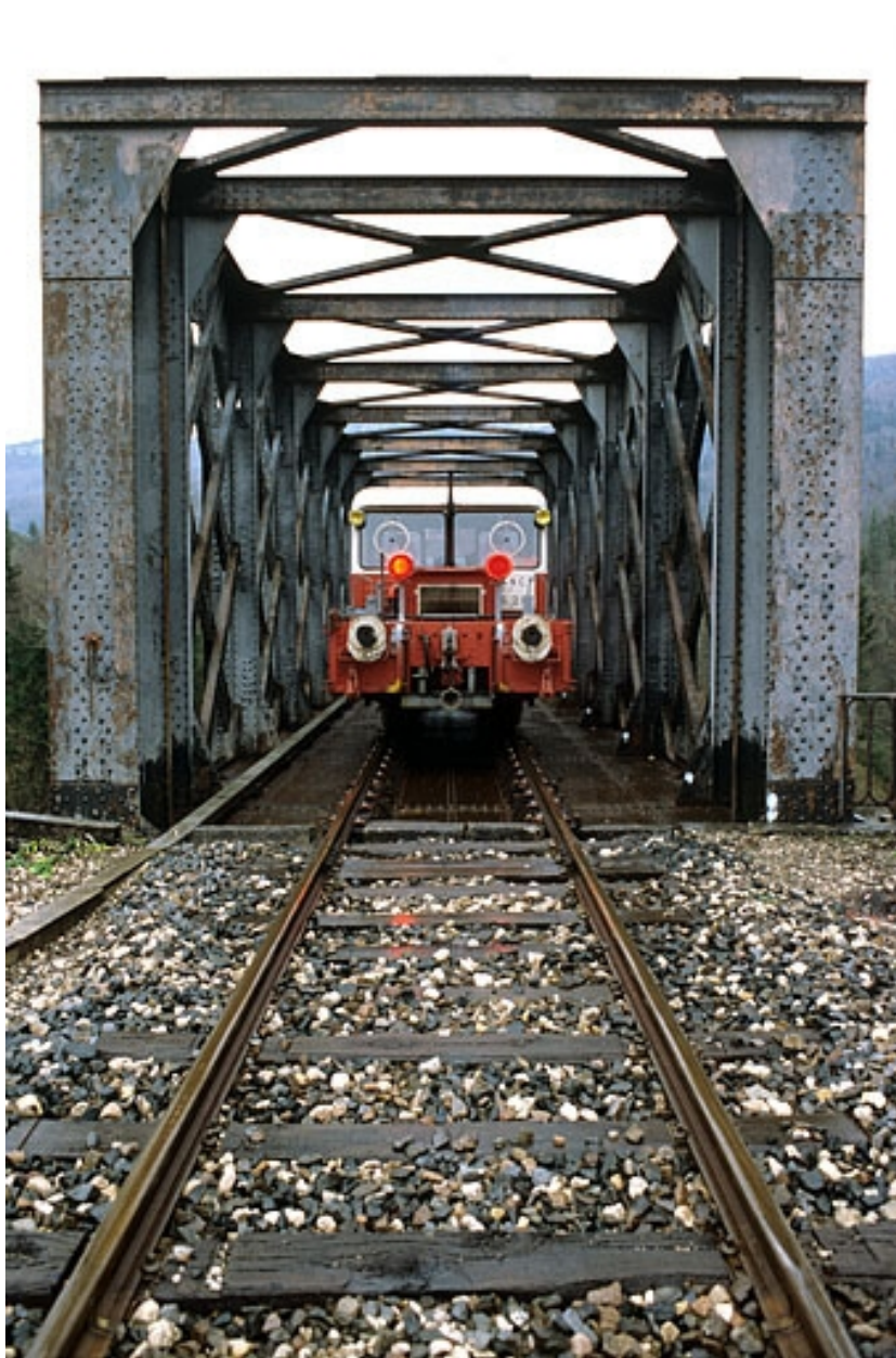
Extrémité côté La Cluse, avec draisine.
