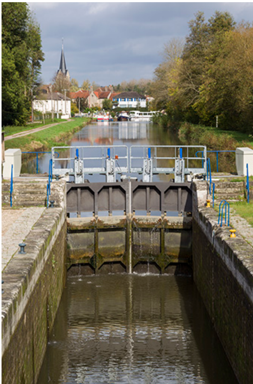
Vue de l'écluse vers l'amont.
