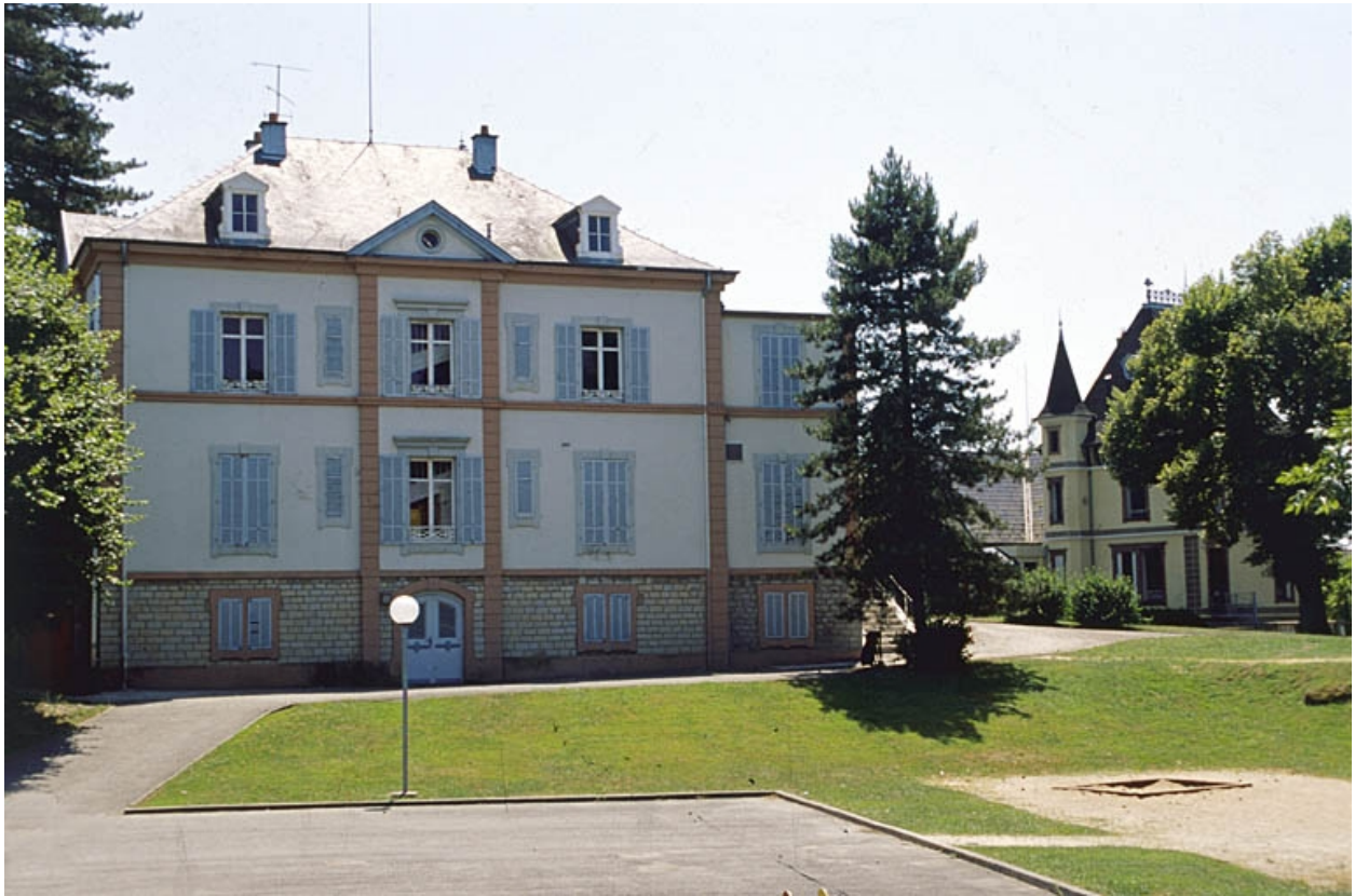
Façade ouest du logement patronal.
