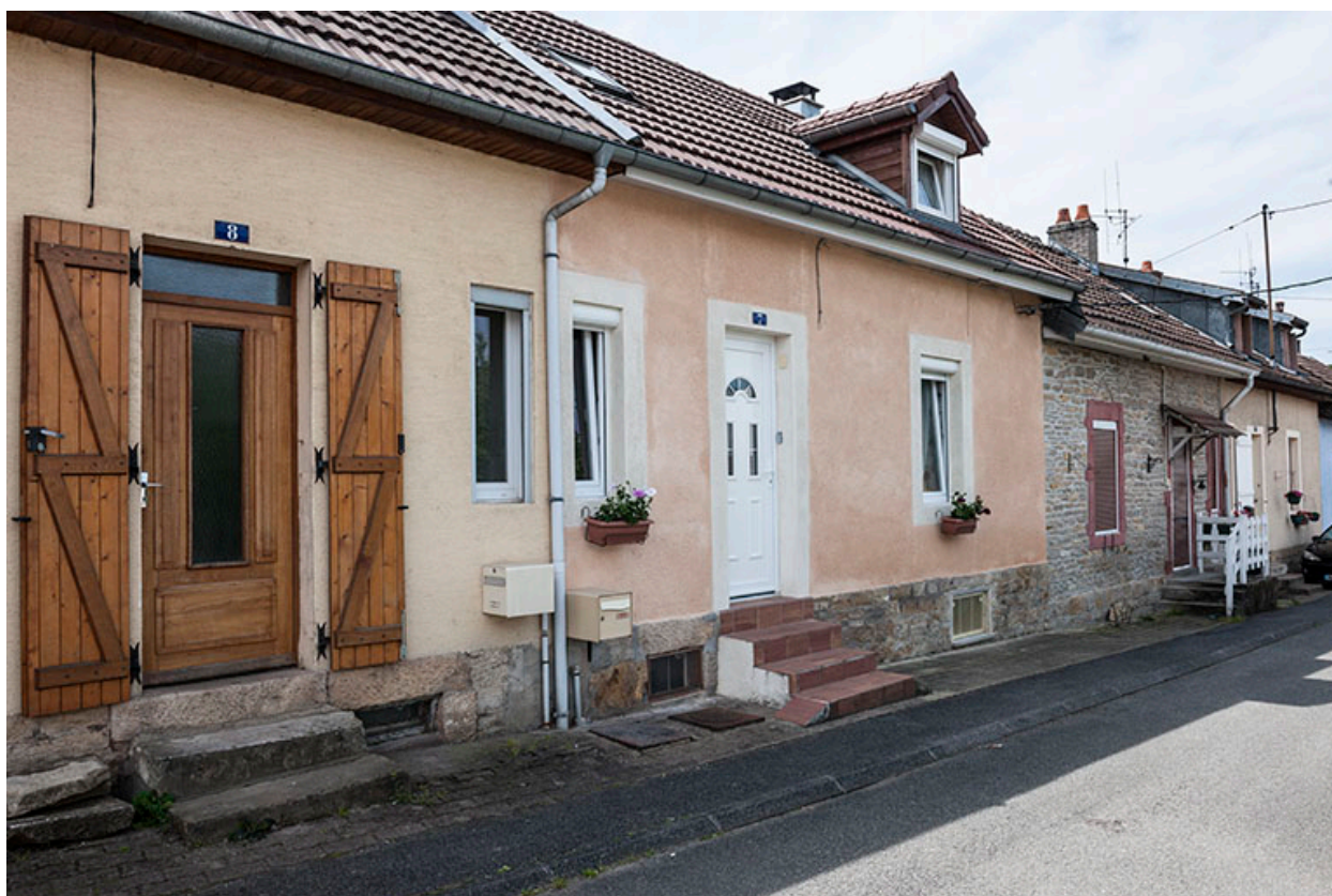
Façades nord rue de la 3e Cité.
