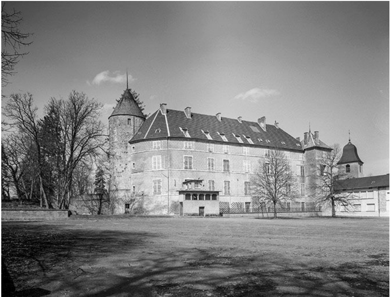
Façade sur le parc.
