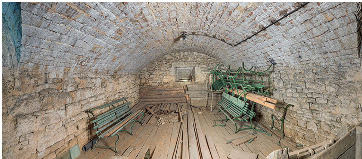
Vue générale d'une casemate.
