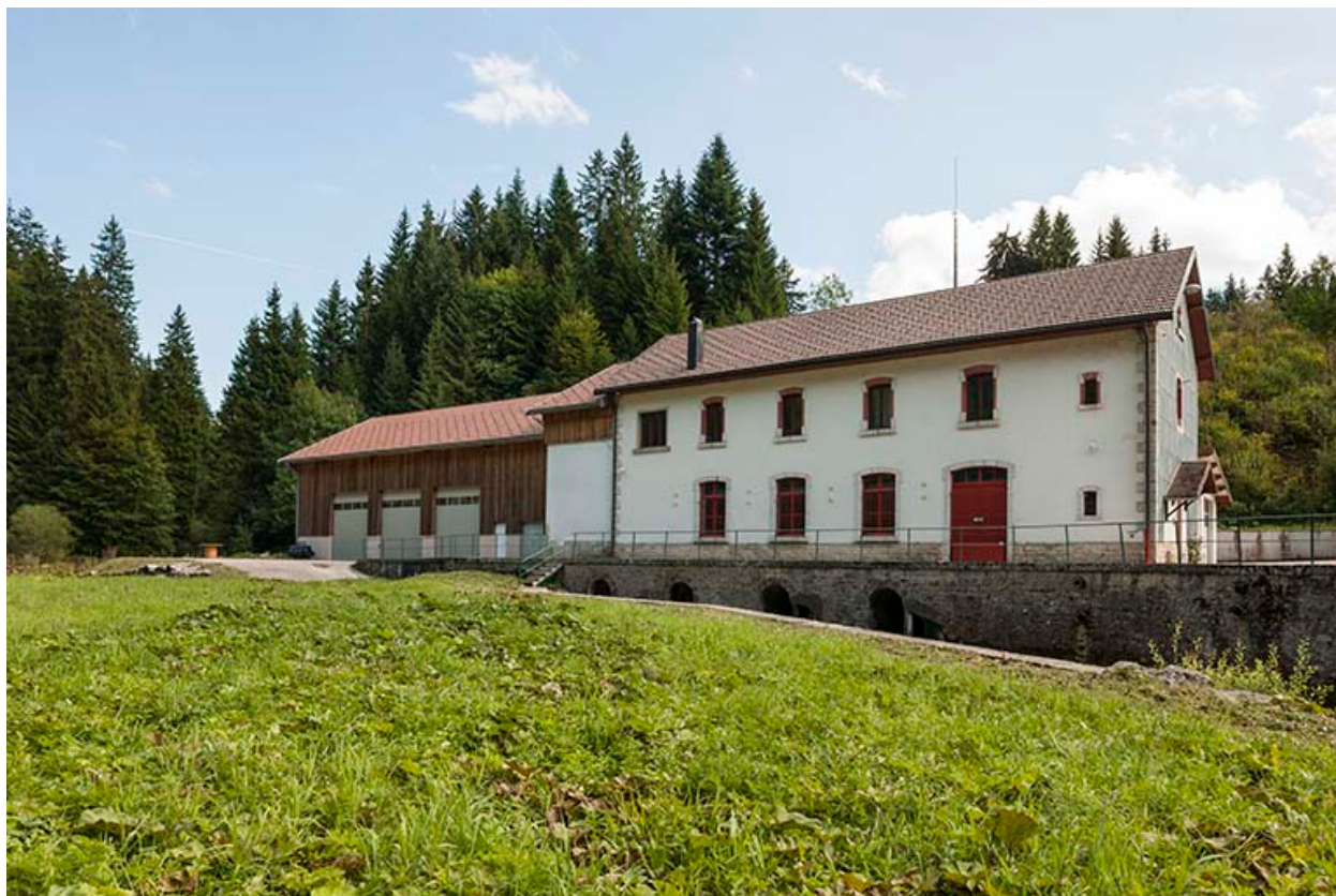
Façade nord vue de trois quarts.
