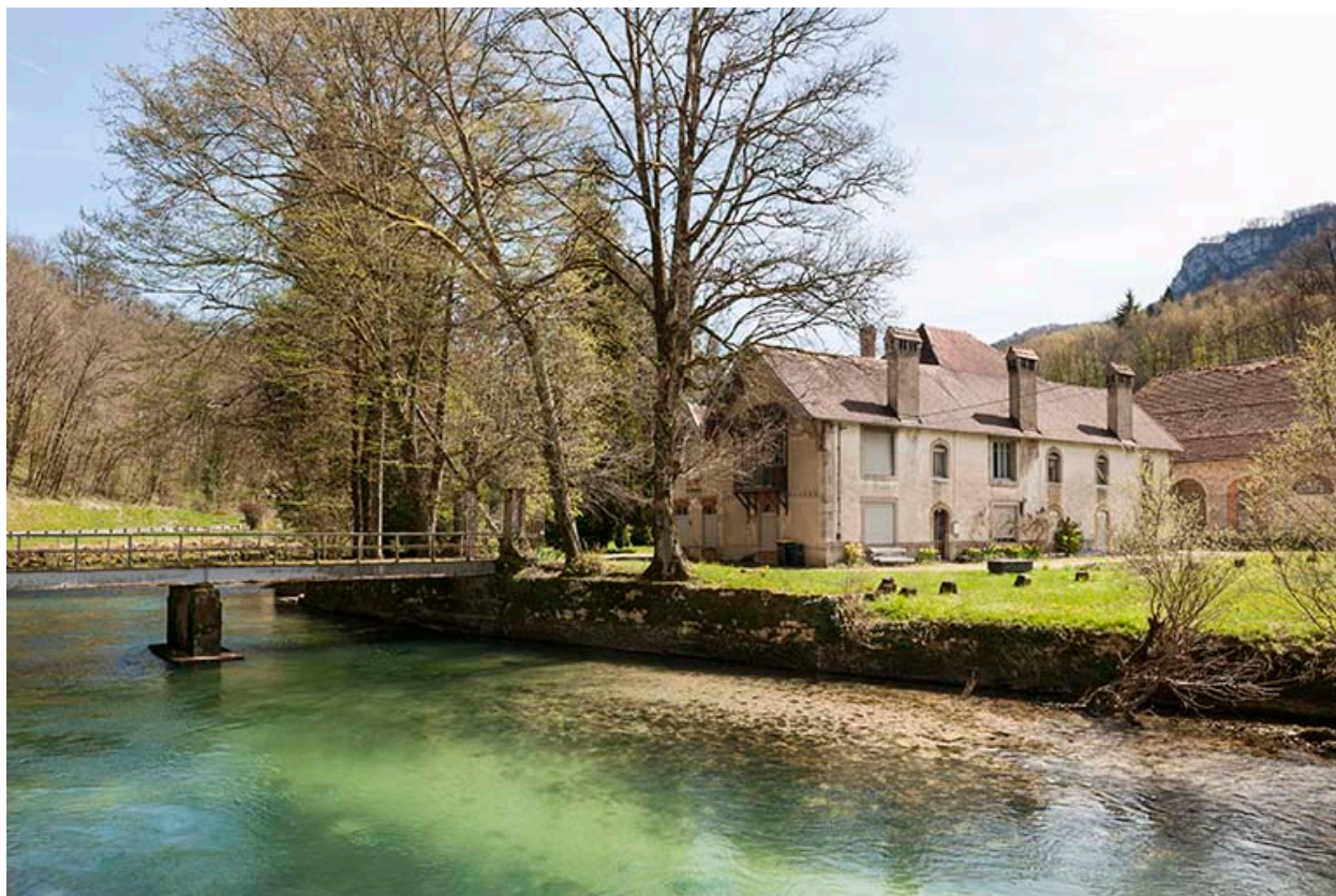
Logement patronal depuis le nord-ouest.
