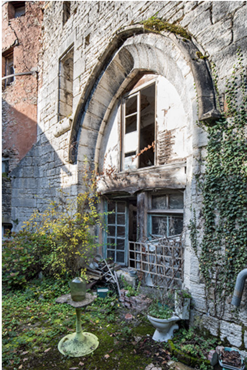
Fenêtre à arc brisé du chevet, vue de trois quarts.
