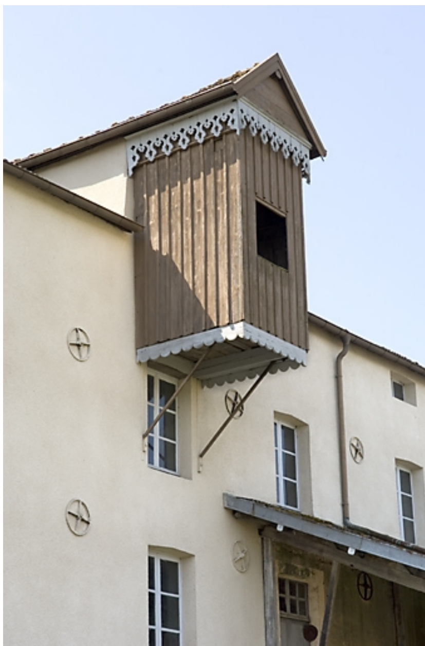
Façade antérieure. Edicule du monte-sac.
