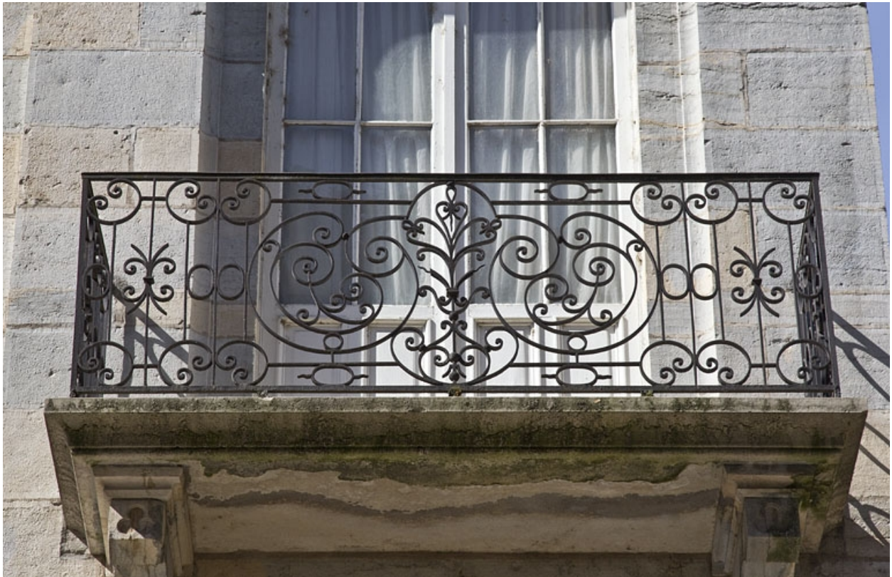
Logis principal : détail d'un balcon en ferronnerie.
