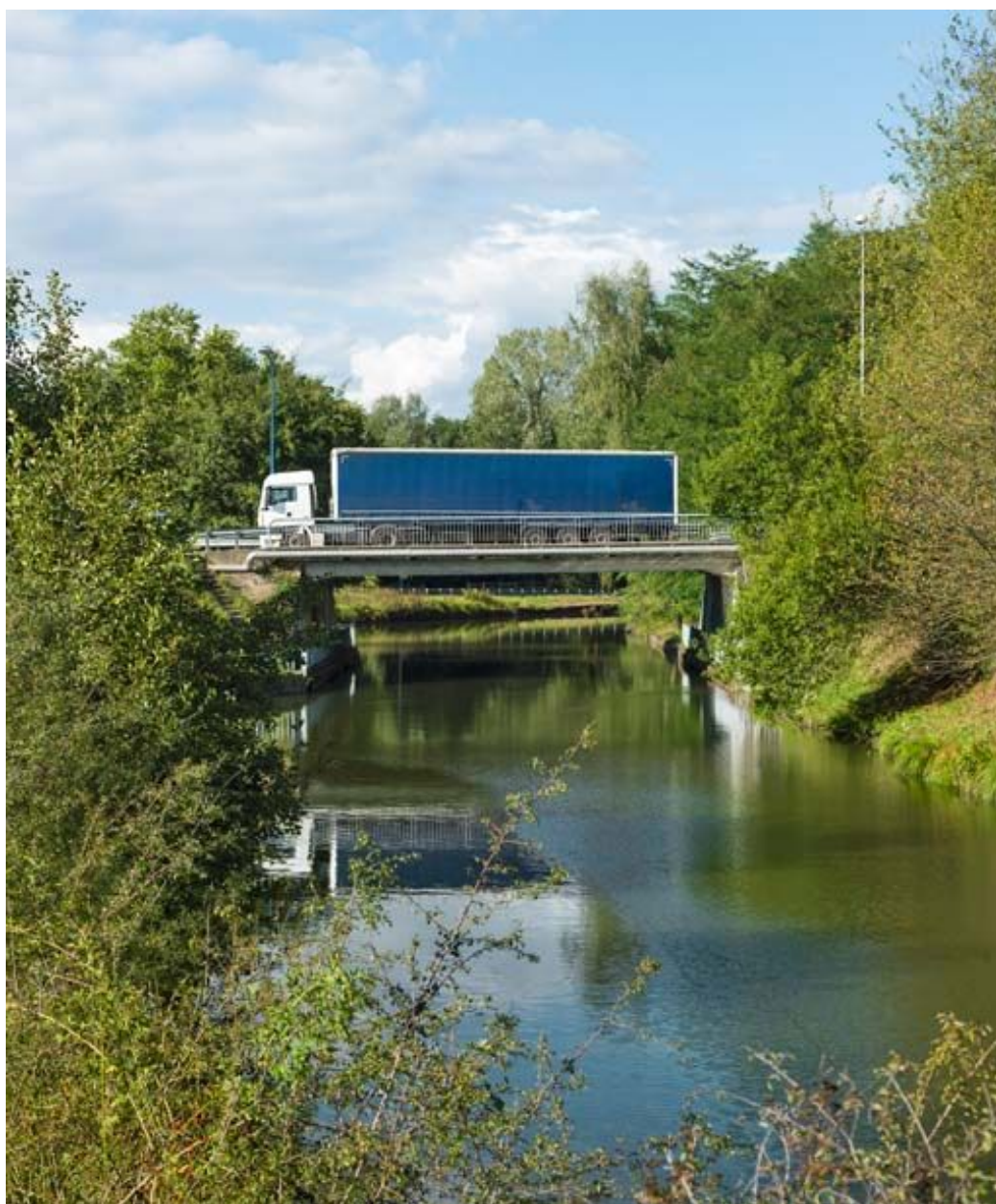
Vue d'ensemble du pont.
