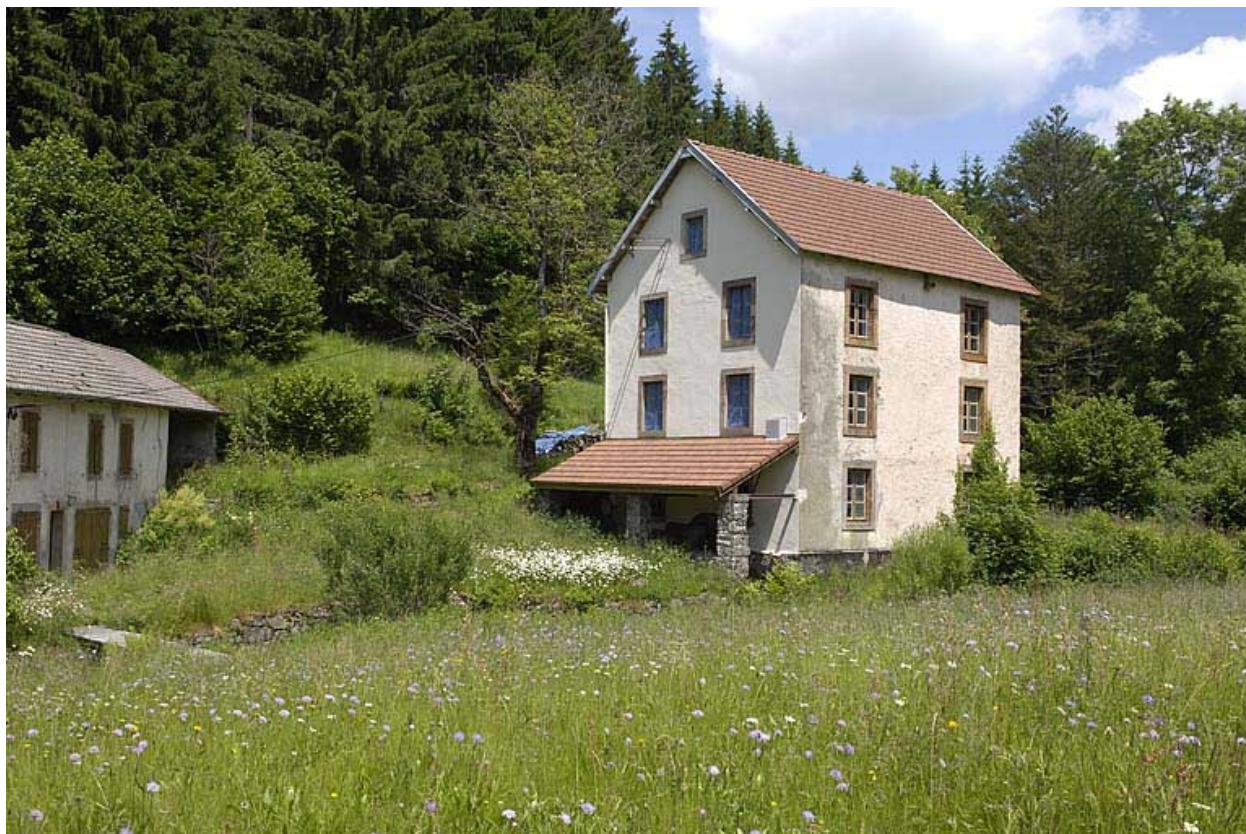
Le moulin vu depuis l'ouest.
