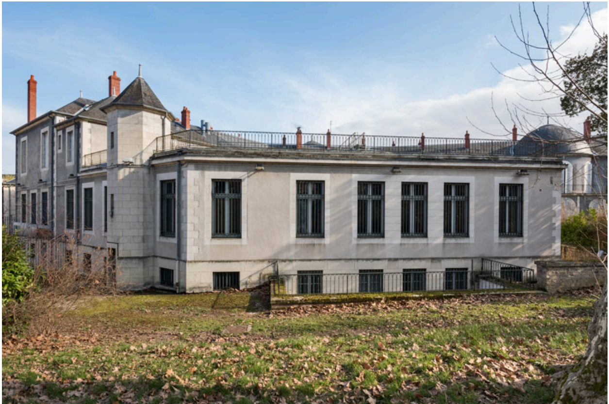
Façade sur le jardin, extension de 1924-1926, côté nord-ouest.
