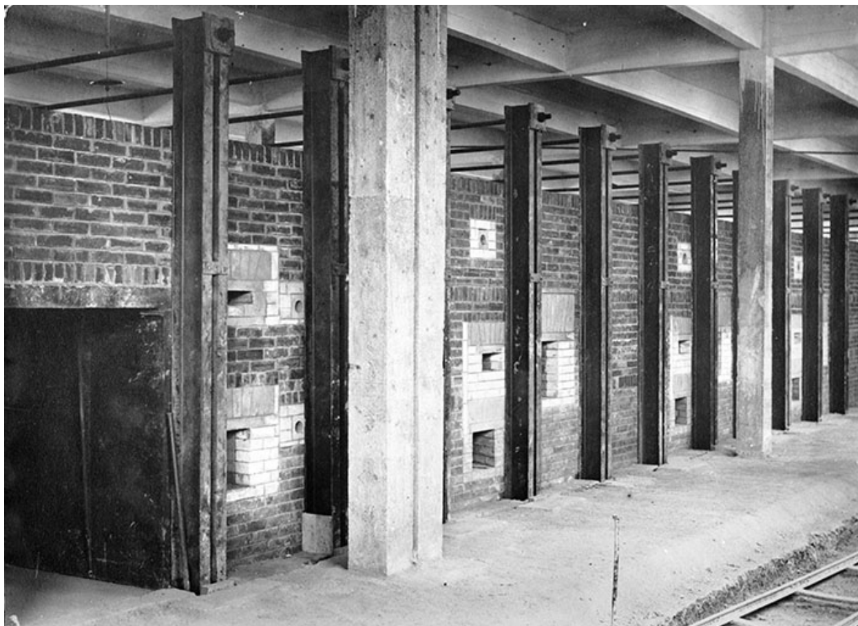
Four Dressler en construction : vue latérale.
