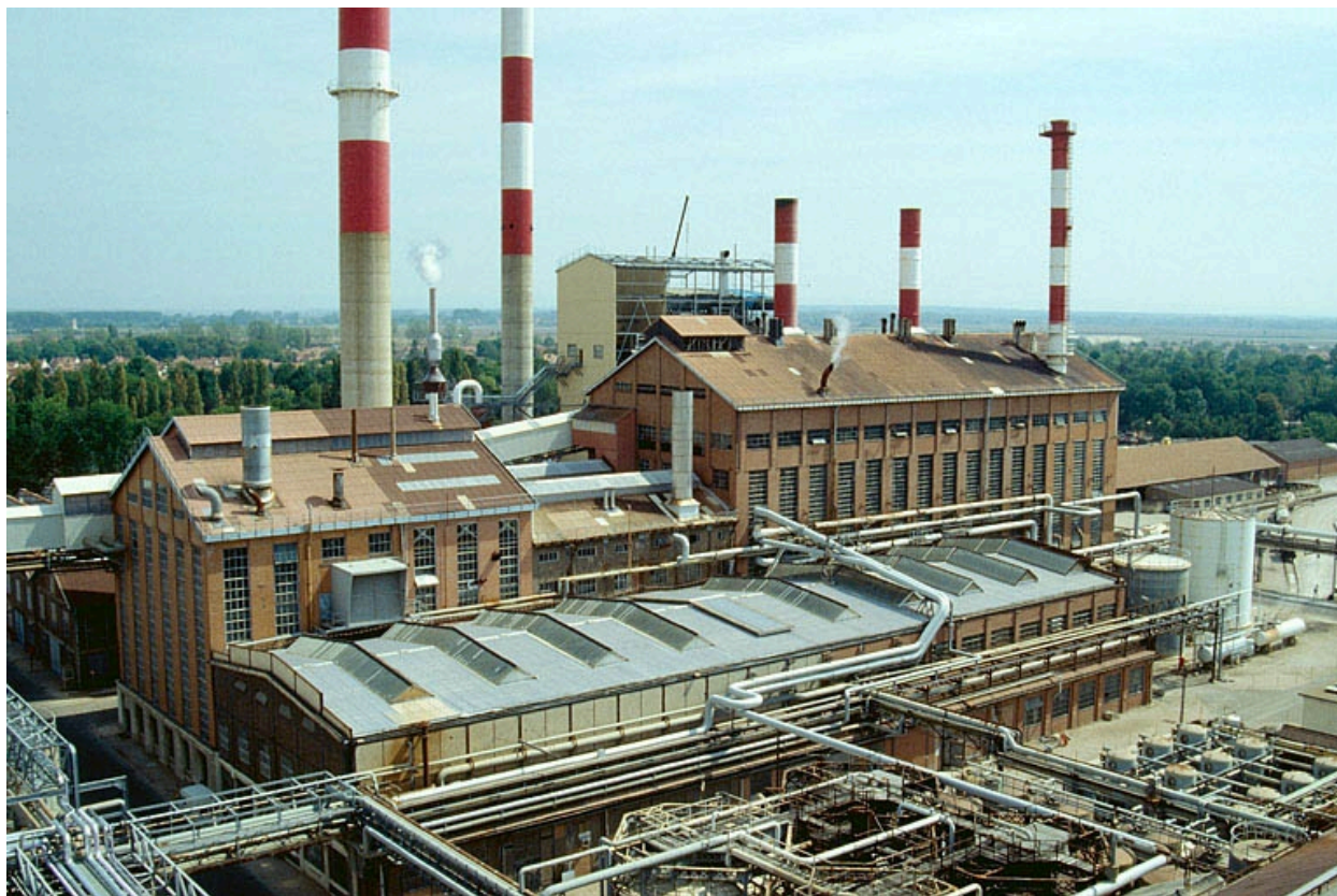
Usine de produits chimiques de la société Solvay et Cie, Tavaux et Abergement-la-Ronce : chaufferie et générateurs de vapeur et d'électricité.
