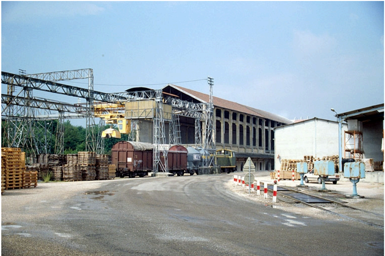
Pont-bascule (40), pont roulant (17) et hangar à terre (18).
