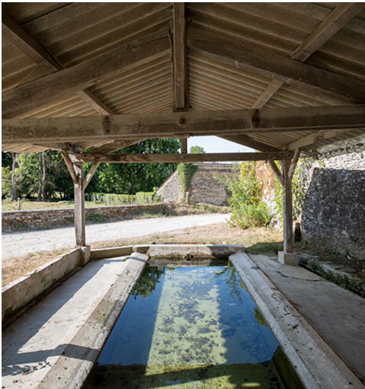
L'intérieur du lavoir vers l'entrée.
