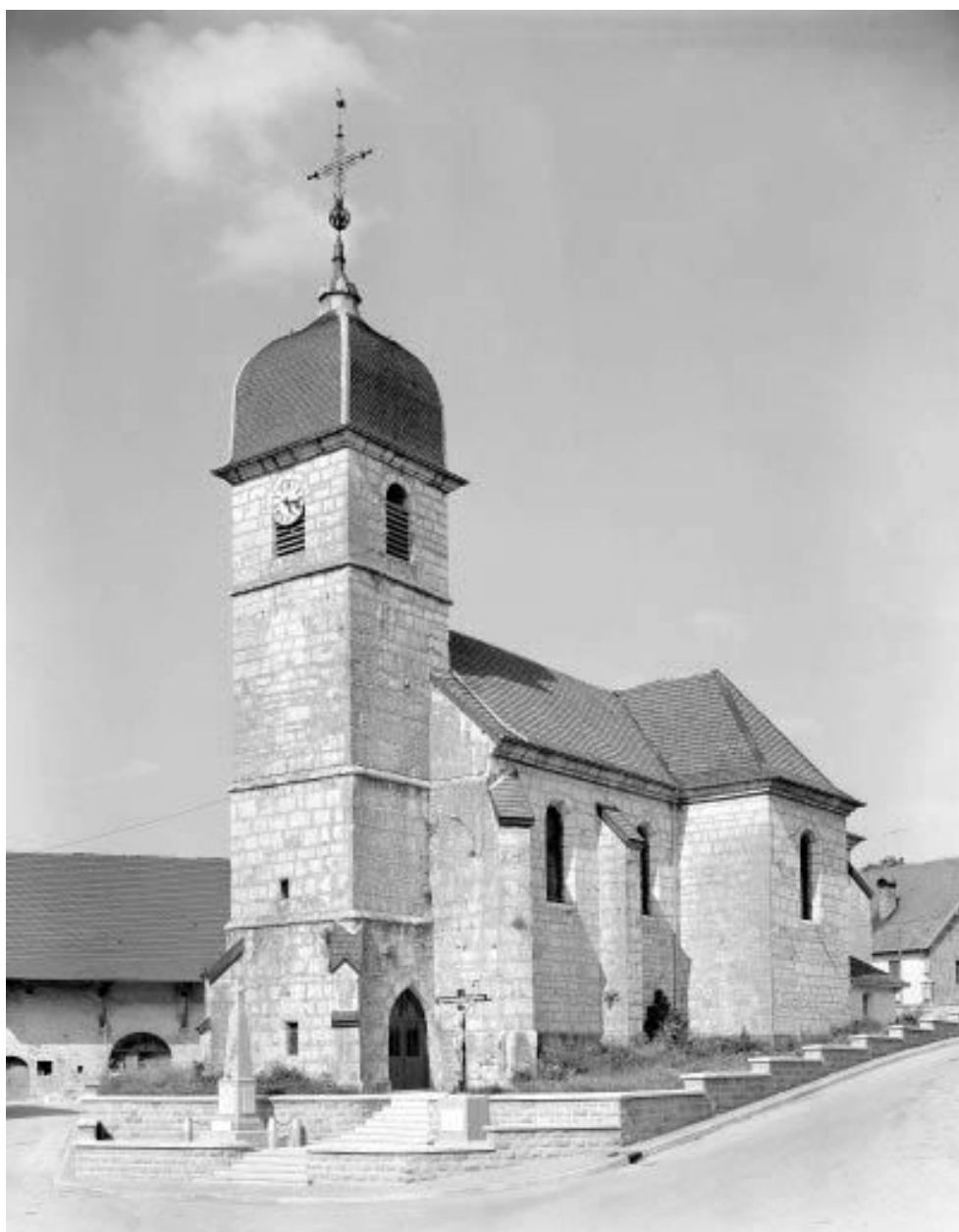
Facades antérieure et latérale droite.
