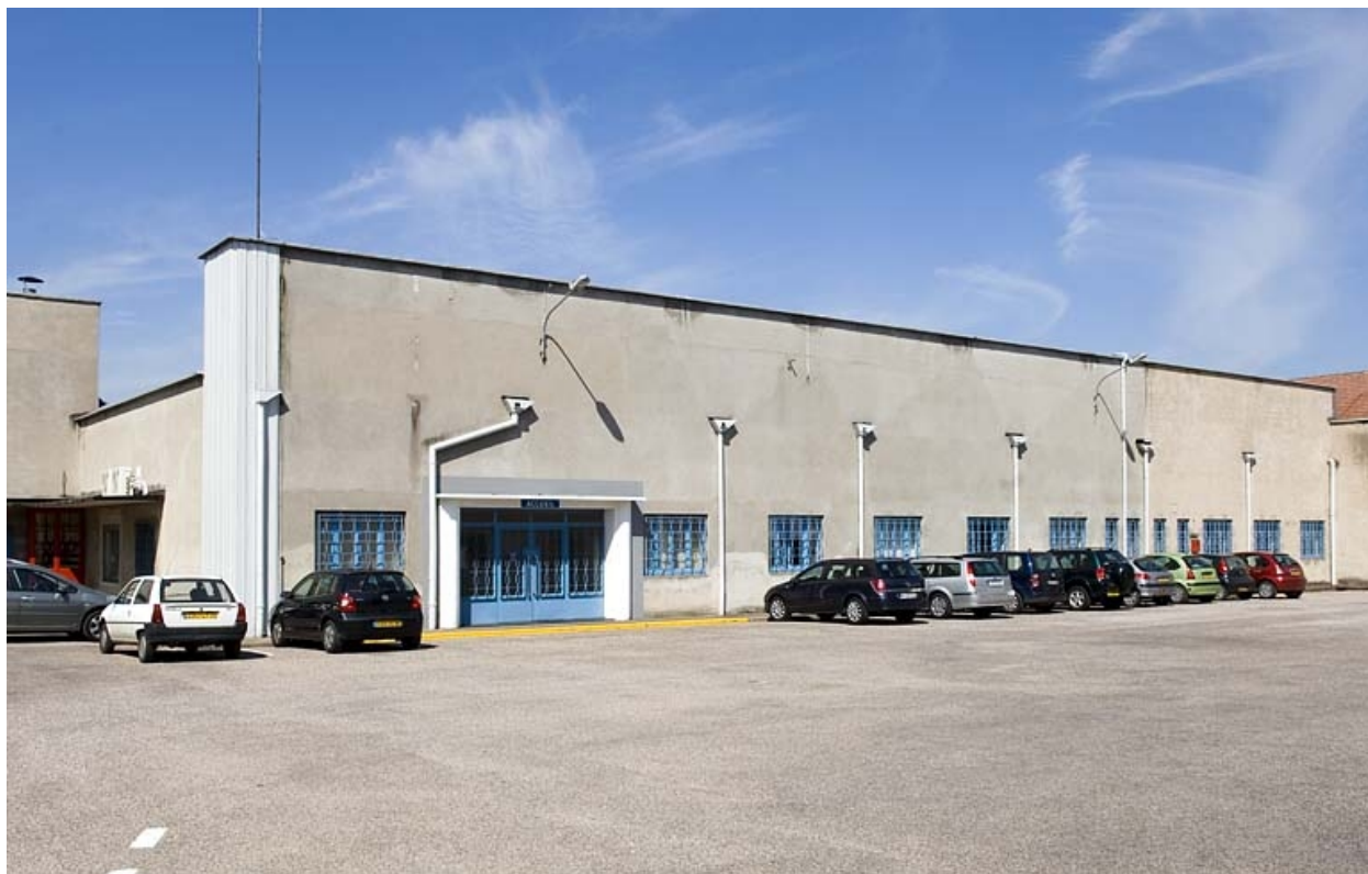
Façade des bureaux.
