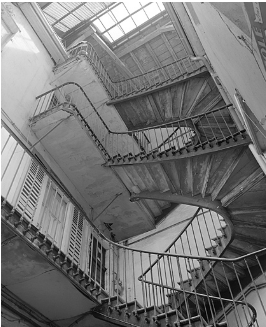
L'escalier, vue générale.
