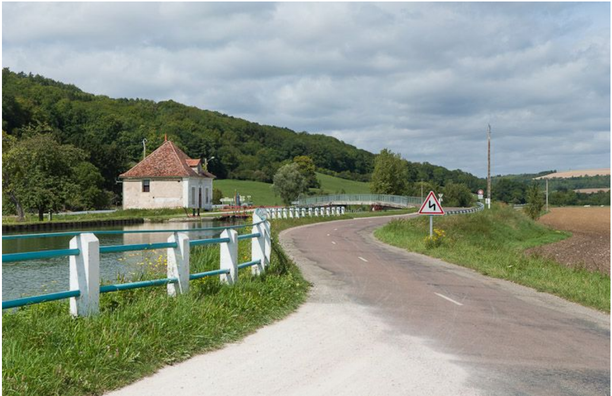
Vue du site d'écluse depuis la route.
