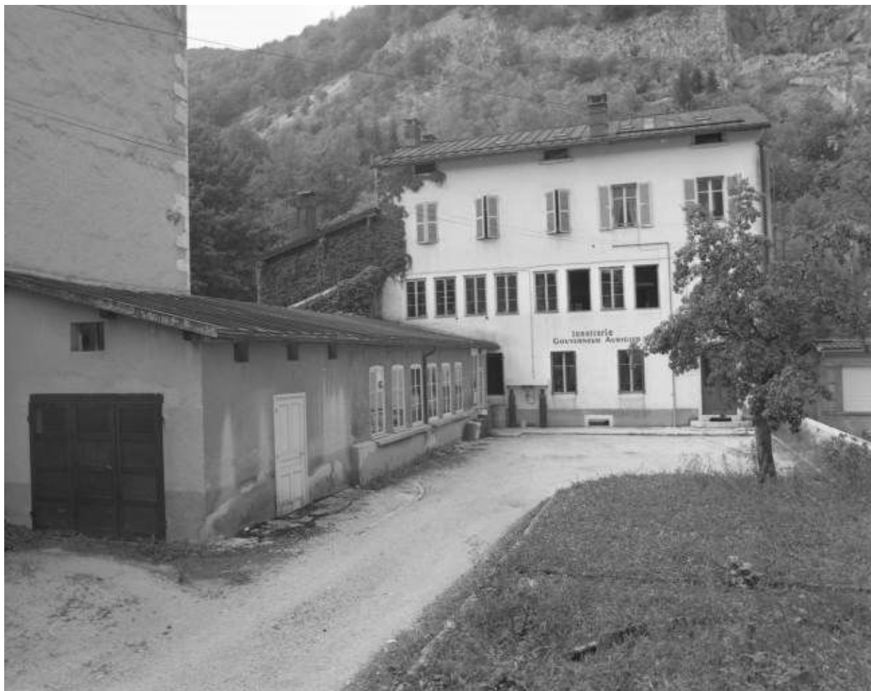
Cour et façade antérieure.
