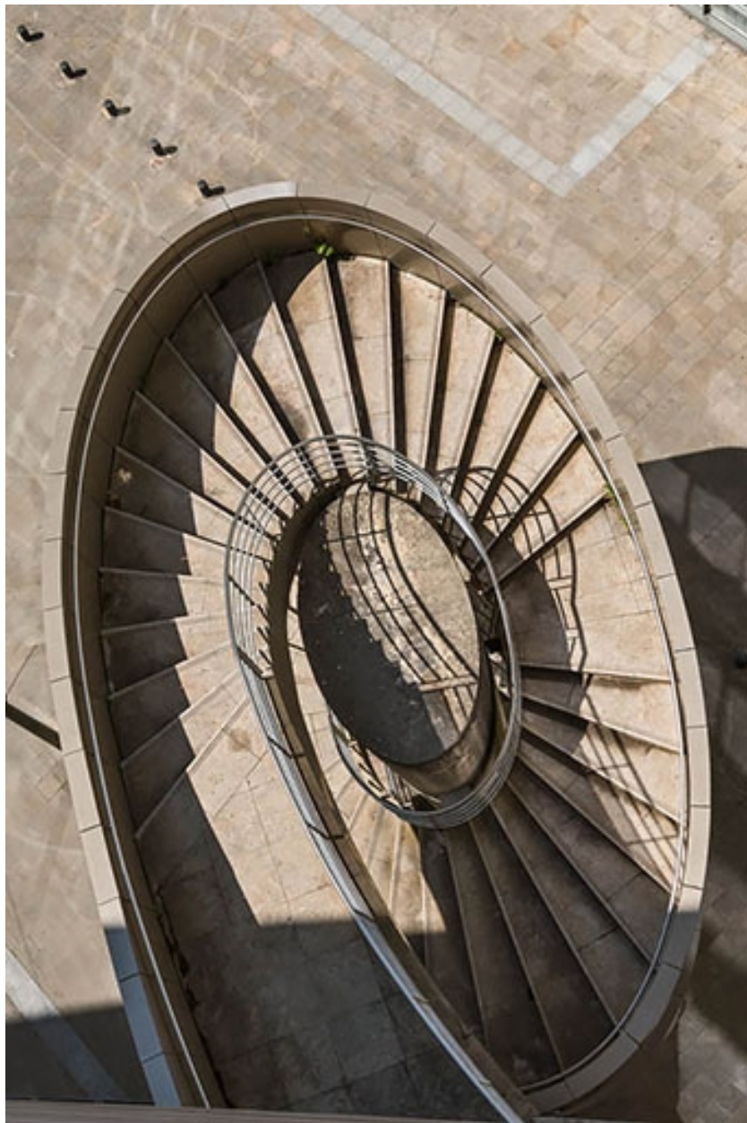
Corps d'entrée : escalier extérieur en vis, vu du haut.
