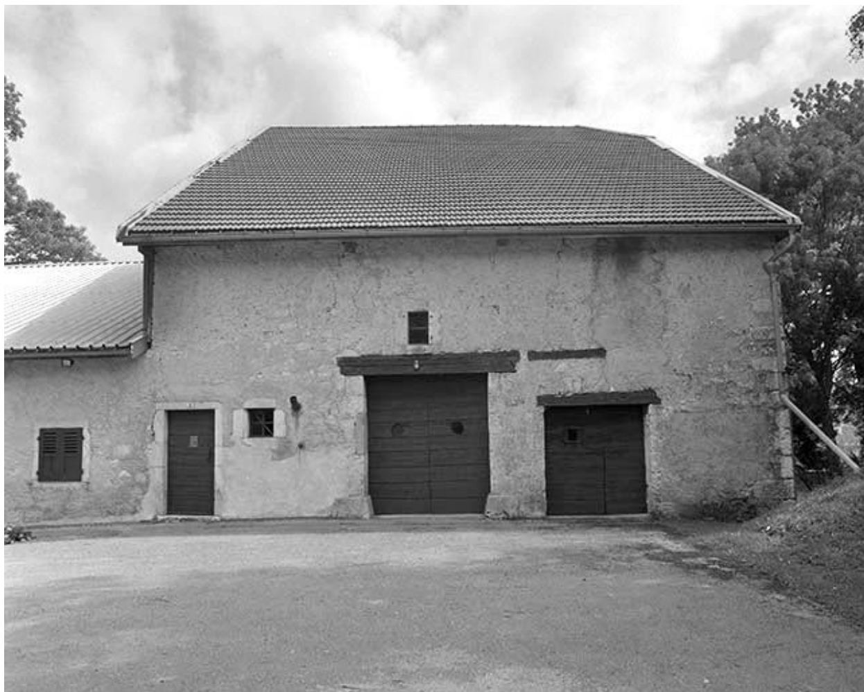
Façade postérieure de la ferme de gauche.
