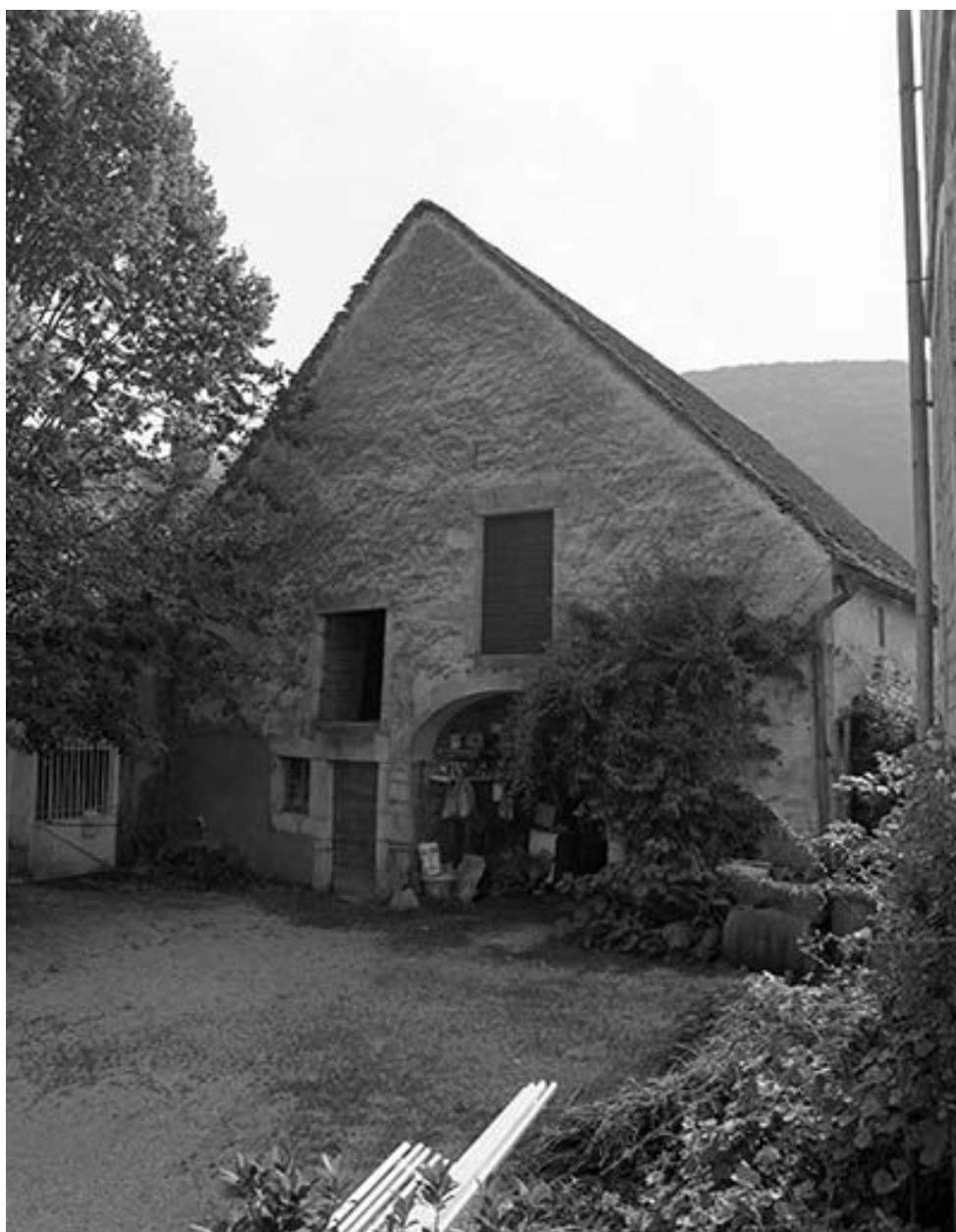
Façade antérieure des parties agricoles.
