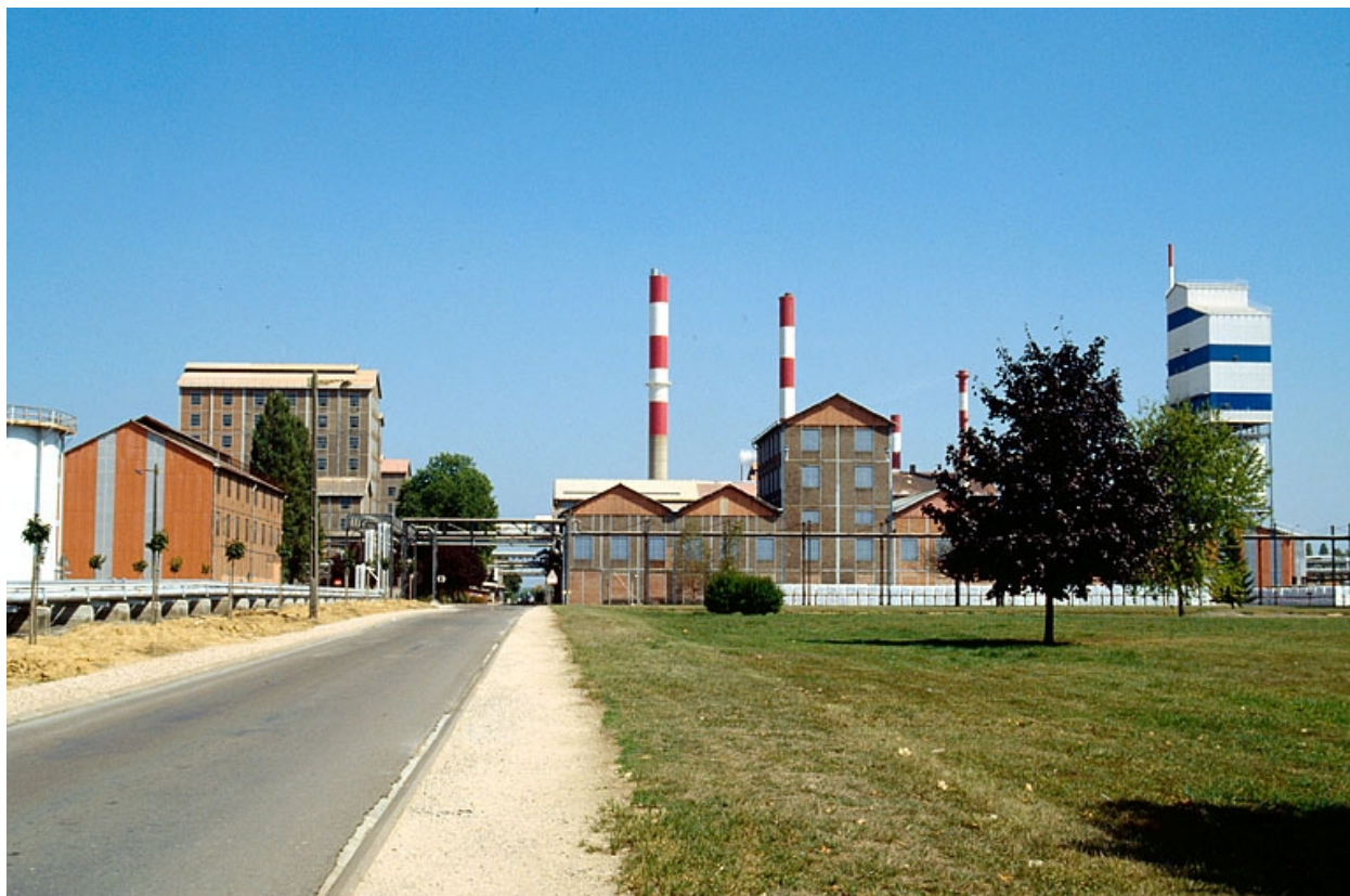
Soudière (10) et ancien atelier du chlorure de calcium (à l'extrémité de la caustification 20), vus de l'ouest.
