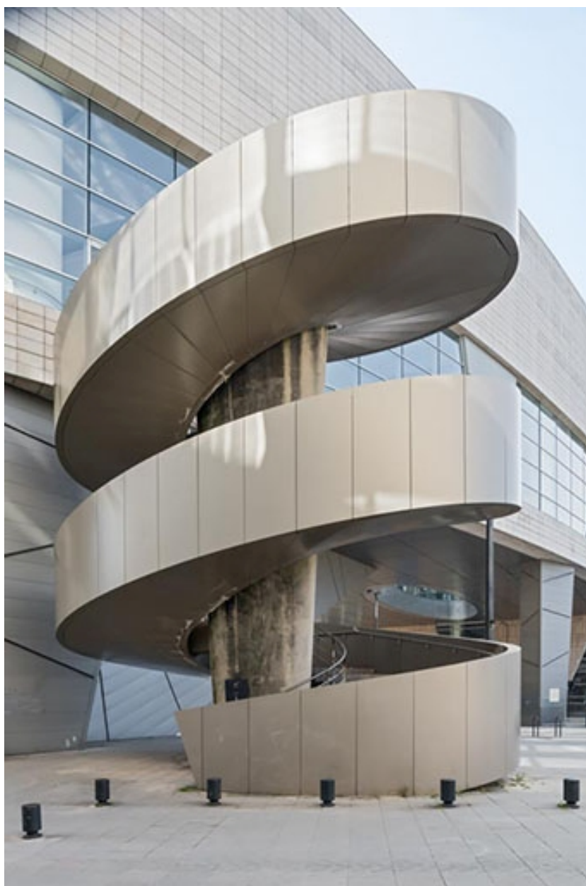
Corps d'entrée : escalier extérieur en vis (vue rapprochée).
