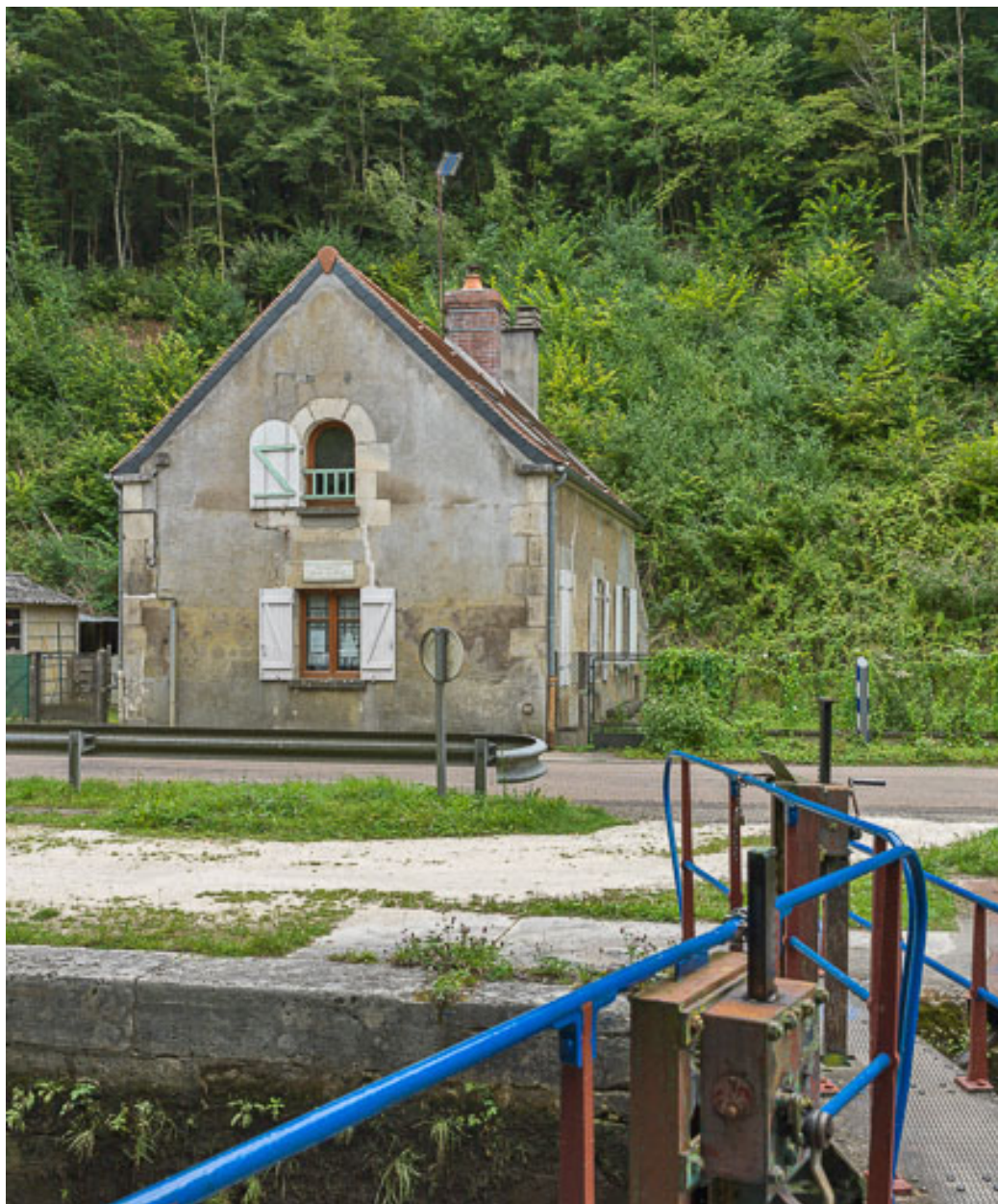
Vue de la maison éclusière.
