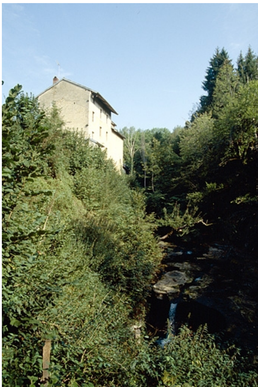
Façade postérieure du logement patronal.
