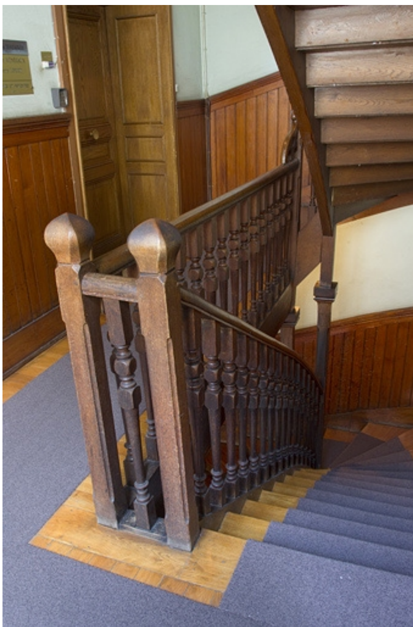
Intérieur, escalier : vue d'ensemble.
